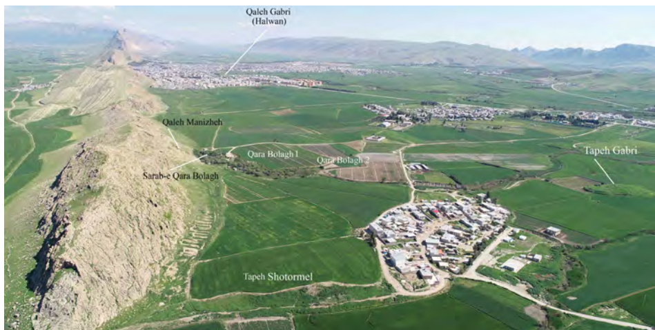
تصویر ۴. دورنمایی از مجموعه قه بلاغ سرپل زهاب، تپه شترمل و قلعه مریم / منیزه (دید از غرب، عکس از رضا عزیزی)
